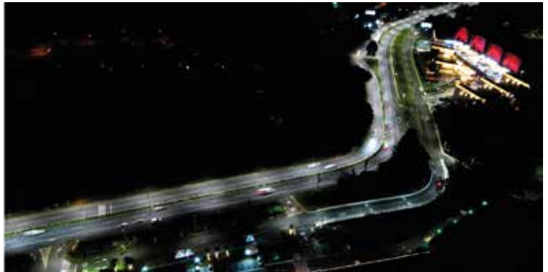
Vía Las Palmas - 736 luminarias
