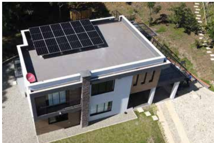
Casa Barbosa - 7 kWp
